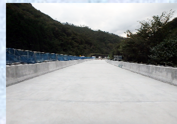
床版取替完了 (床版上面の開口部を一切排除)
