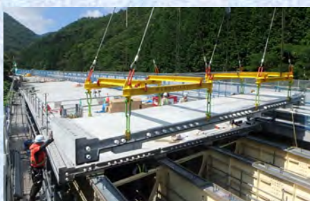
Dura-Slab の架設状況
