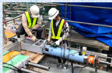
床版縦締めアラミド FRP ロッドの緊張状況
