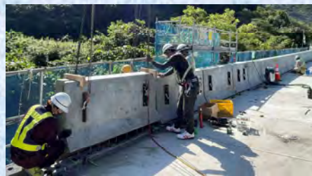
Dura-Barrier の架設状況
