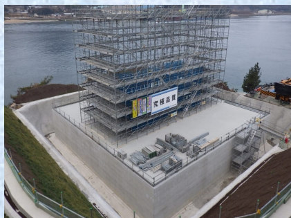
基礎橋脚施工状況
