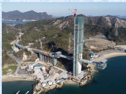
PC 桁張出し架設状況
