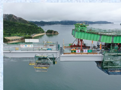
鋼桁閉合ブロック架設状況
