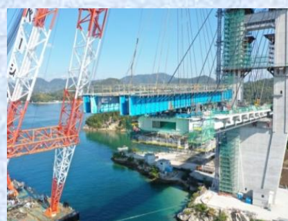
鋼桁 EN 設置状況
