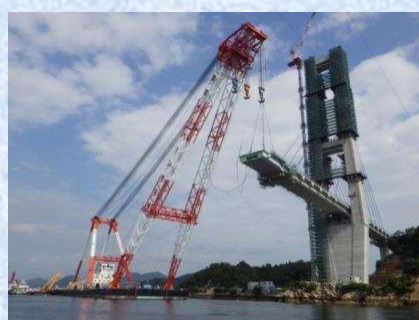
鋼桁 (1BL) FC 船架設状況
