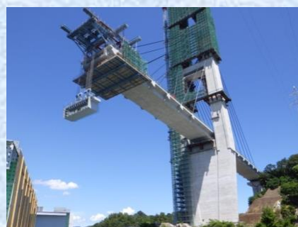
接合桁架設状況
