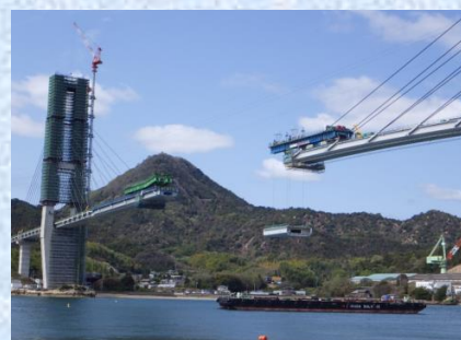
鋼桁 (2BL 以降) EN 架設状況
