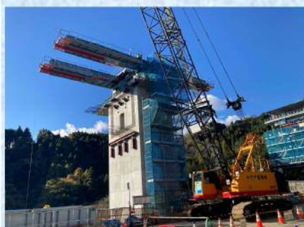
移動作業車組立状況
