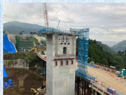
柱頭部施工完了状況
