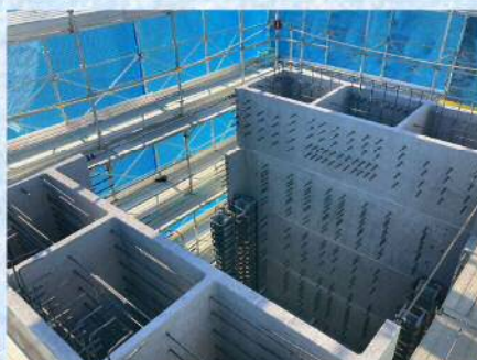
プレキャスト部材設置完了状況
