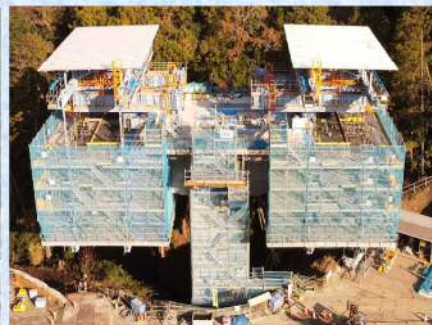
1ブロック以降張出し施工状況
