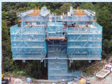
0ブロック張出し施工状況
