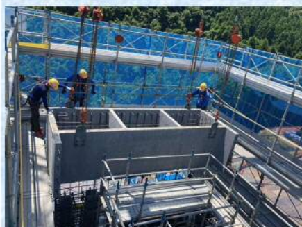
プレキャスト部材架設状況
