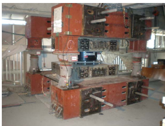
【免震装置の設置作業状況】
