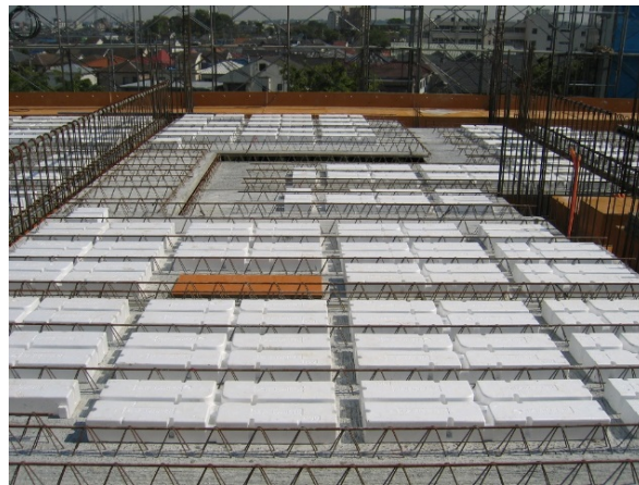
【一般的なボイドスラブにおけるボイド材の設置状況】
