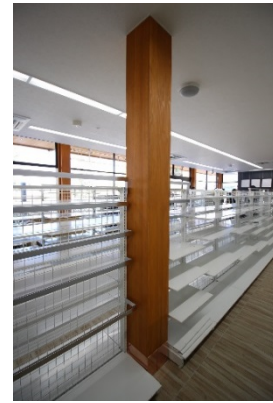
【柱に使用された純木質耐火集成材「木ぐるみFR」(※3)】
