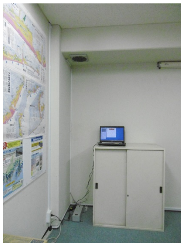
【支店の建物での設置状況】
