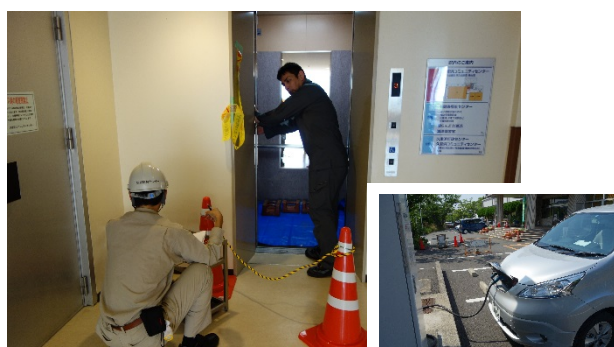
【エレベーター稼働実証実験の様子】
