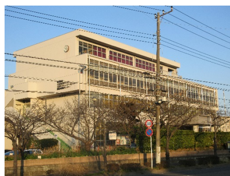
【横須賀市役所久里浜行政センター】
