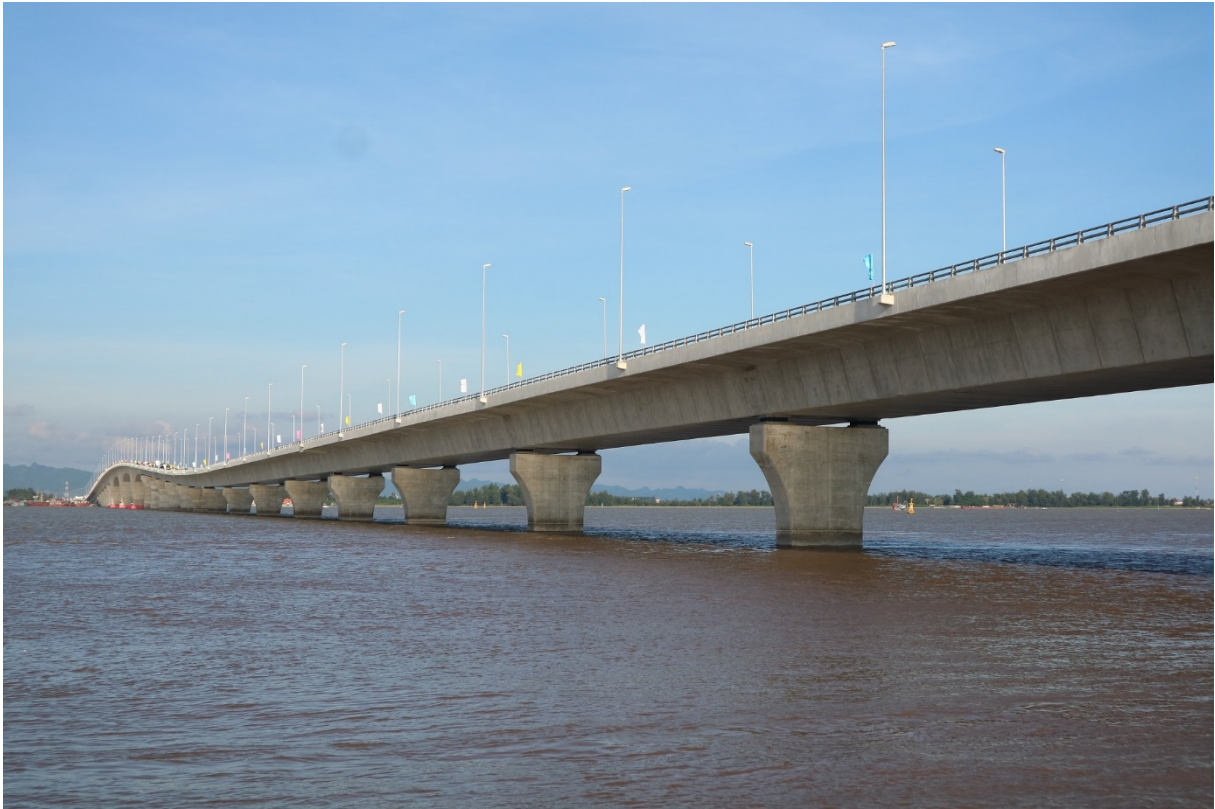
【完成したラックフェン国際港建設事業（海上橋部分）】
