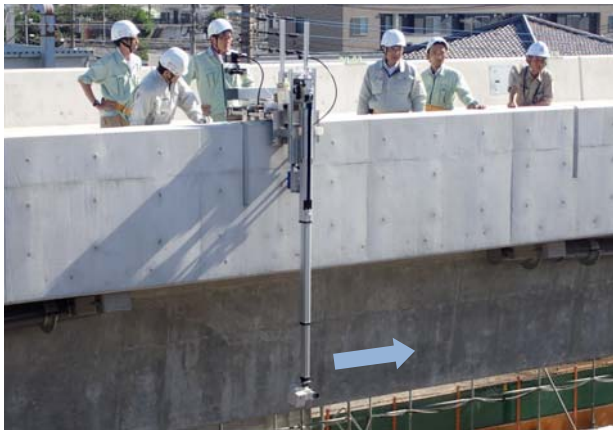
【橋梁建設現場での実証の様子】
