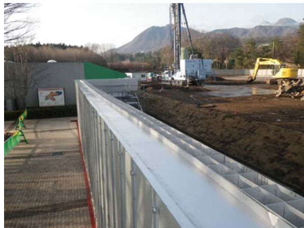
【現場での設置状況】
